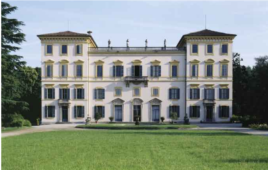
Veduta della Villa dal Pianoro di san Francesco. View of the Villa from St. Francis Sward.
